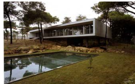
Vivienda en Cascais, 2002
